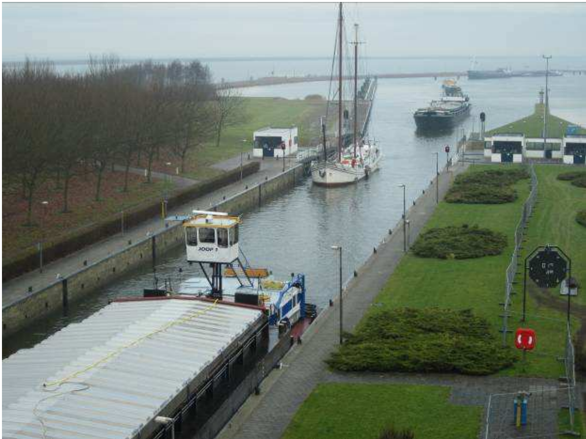
Beeld van Houtribsluizen bij het binnenvaren van schepen
