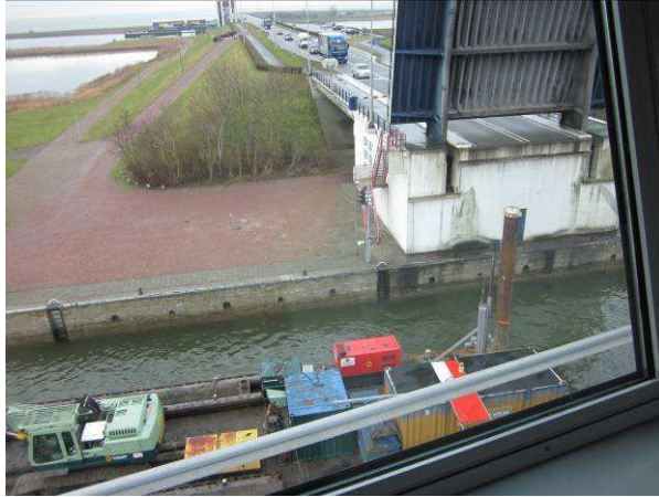
Brug opnieuw omhoog (Z-N)
