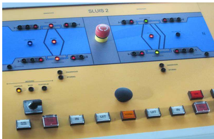
Figuur 1.2: Bedieningspaneel Sluis 2 Houtribcentrale
