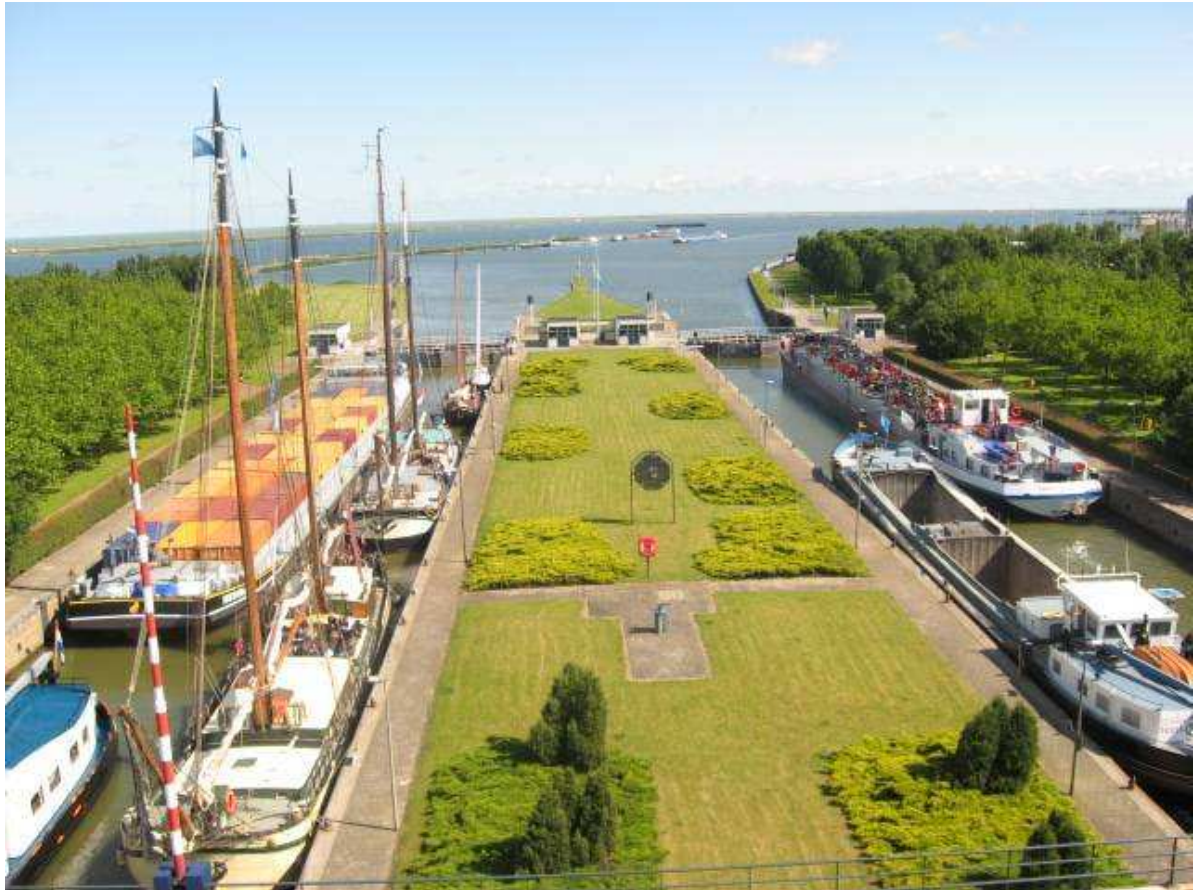
Beeld van Houtribsluizen met gebruik van twee sluiskolken
