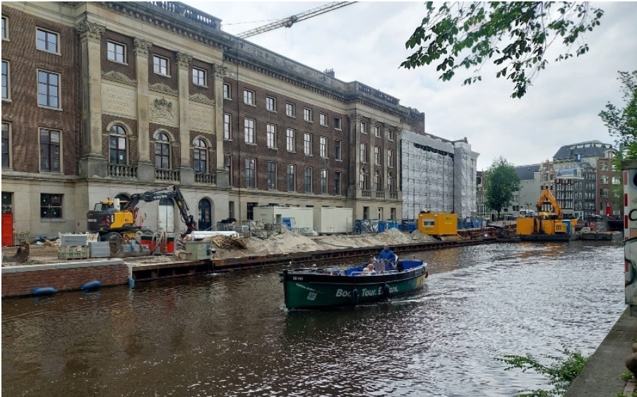
Typerende situatie van een kademuurvernieuwing gecombineerd met maaiveldvernieuwing
